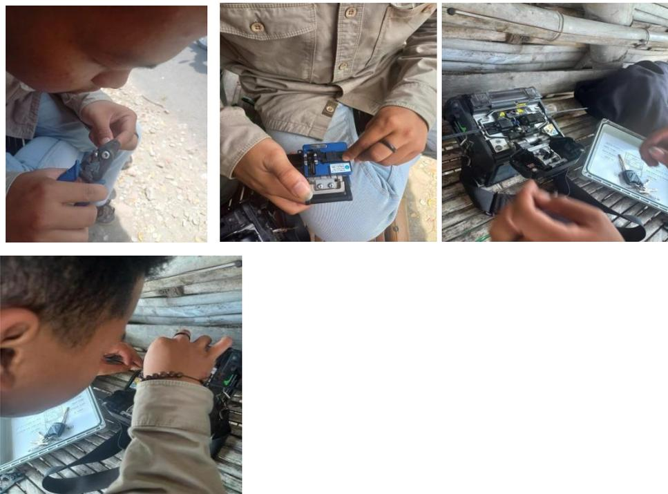
*Gambar 3. 13 cara melakukan splicer kabel optik*
